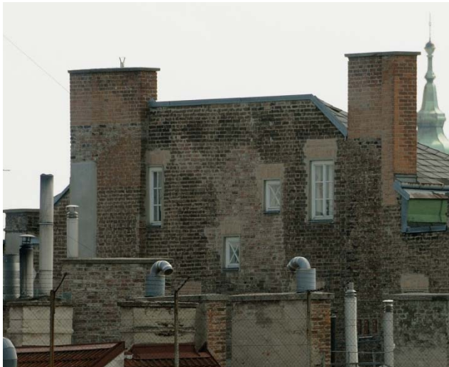
Abb. 16: Feuermauer mit Fenster
